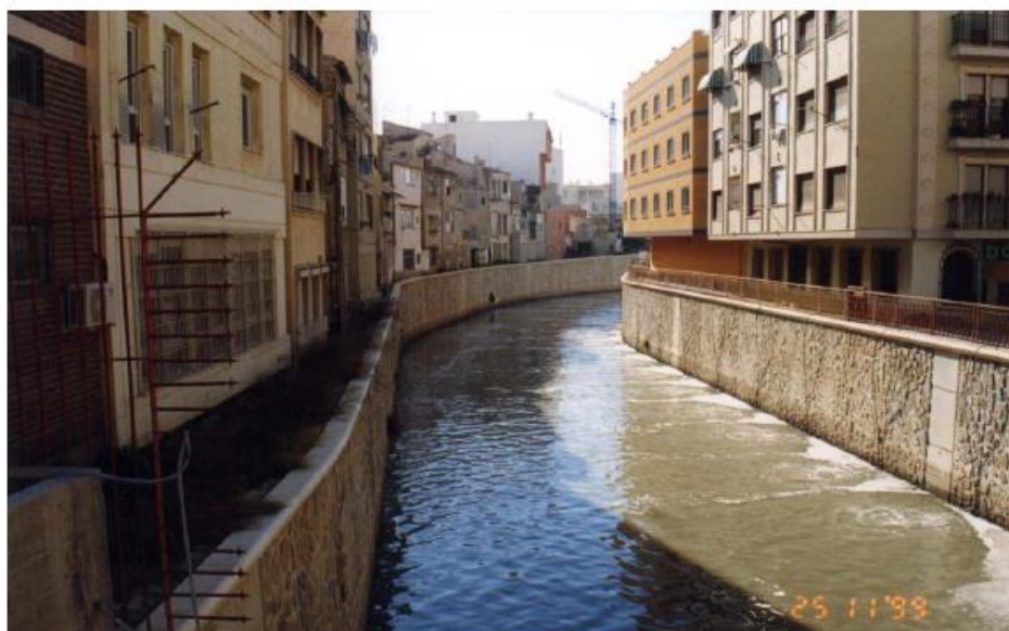
Část kanálu zabezpečeného podzemní stěnou metodou tryskové injektáže. Foto Otto Horský, 1999.
