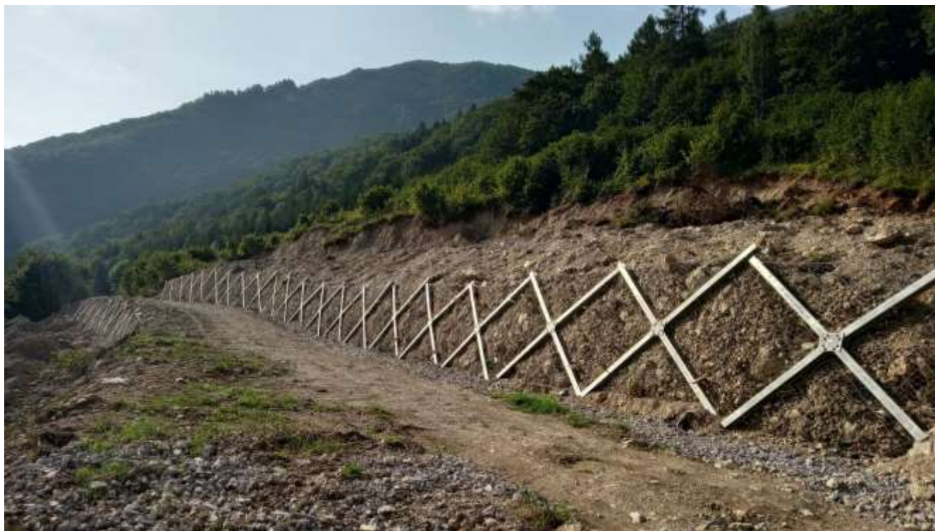
Obr. 1 Stabilizácia časti poľnej cesty vertikálnou vystuženou konštrukciou Erdox Terra
