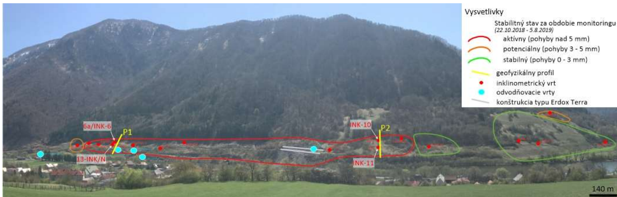
Obr. 4 Schematické znázornenie aktivity zosuvného frontálneho pásma "Kral'ovianskeho zosuvu" s vyznačenou polohou geofyzikálnych profilov (Bednarik a kol., 2019 - upravené)
