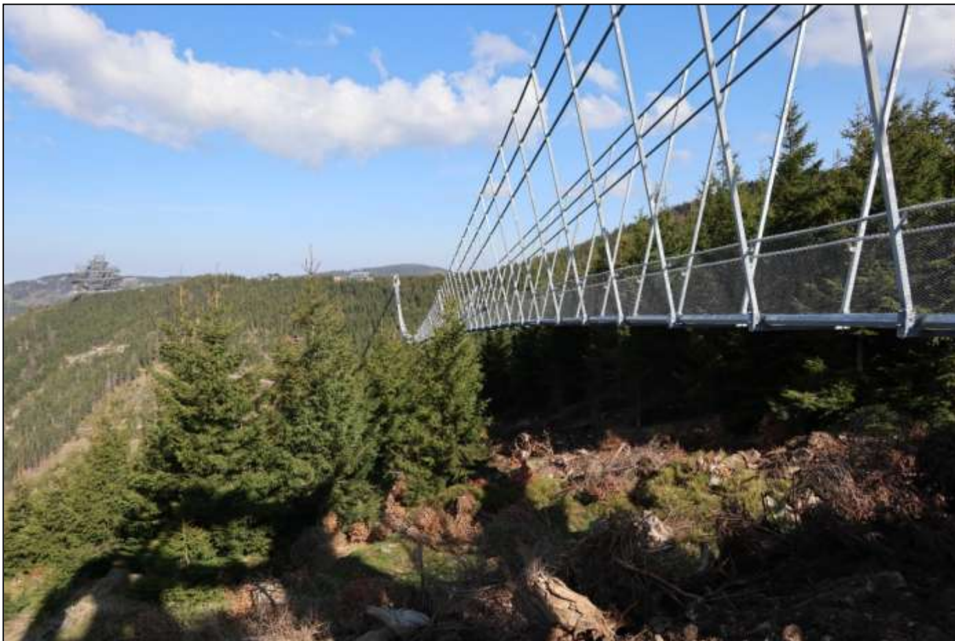
Obr. 1 Monitorovaný objekt: Sky Bridge
