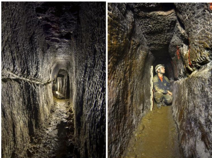
Obr. 10 Chodba CH 211 zvaná „Myší díra“, o výšce 130 cm a šířce 70 cm (Foto Šmehil)
