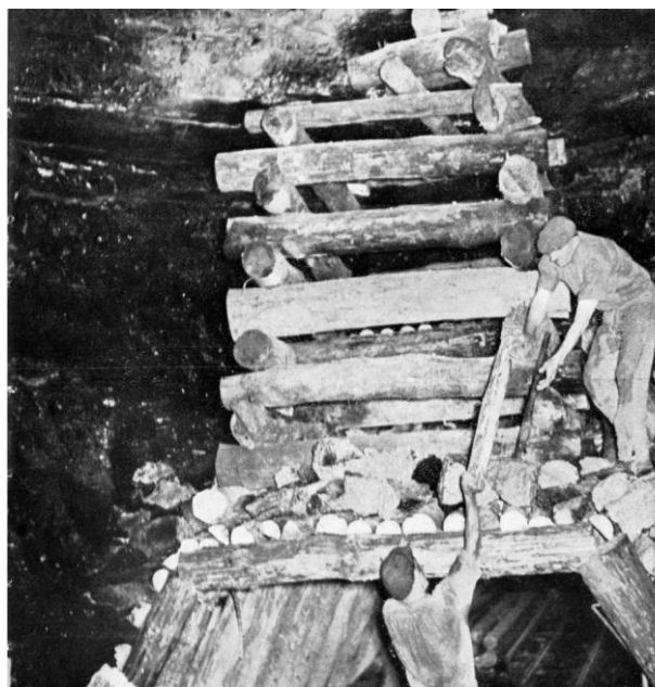
Obr. 34 Hráň budovaná pro zajištění stropu komory nad vstupem do ní. (Foto z UD v padesátých letech 20. stol.)
