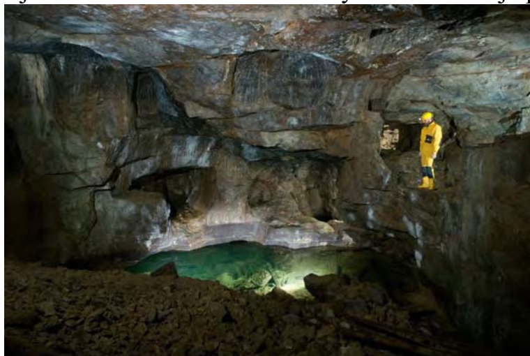
Obr. 4 Pohled na jižní stěnu komory K1; zakouřené stropy, stopy po želízku, ražby spojovacích chodeb, lokální šířiny, zatopené hloubení (foto Tasler, 2009)
