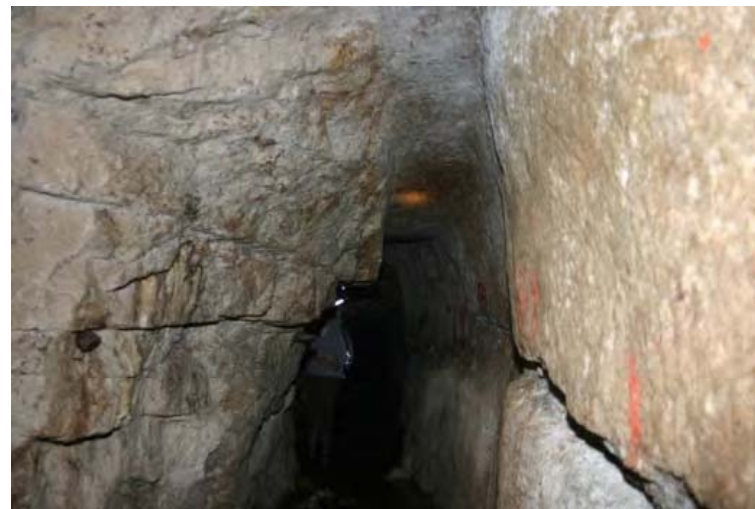
Obr. 1 Nafárání staré chodby novou ražbou (foto Kaláb, 2008)
