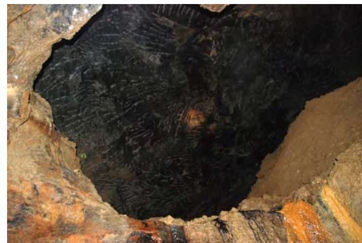
Obr. 5 Černý strop komory při sázení ohněm (foto Klier, 2010)
