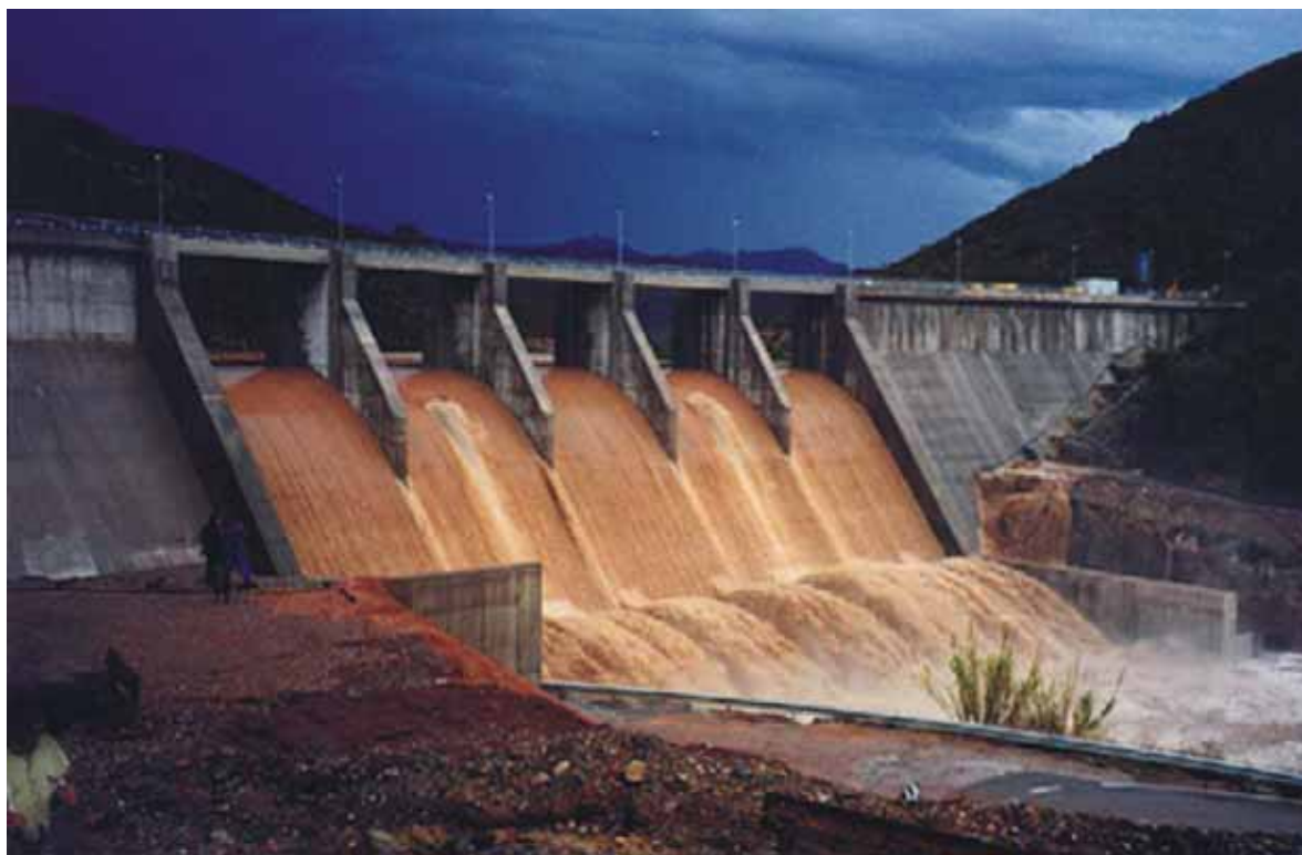
Obr. 2: Úniky vody z podpaty přehradní hráze v době katastrofálních dešťů (přehrada Algar podzim 2000)
