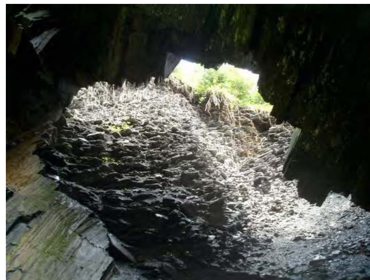
Obr. 6 Pohled z dolu na situace propadu do starého důlního díla v Čermné ve Slezsku
