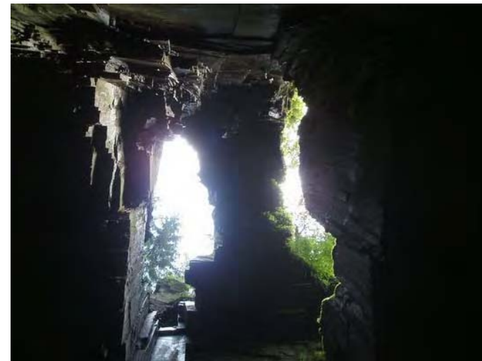
Obr. 7 Pohled z dolu na situace propadlých komor starého důlního díla v Čermné ve Slezsku
